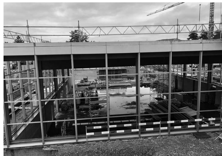
Auen – Sporthallenenerweiterung im Rohbau
