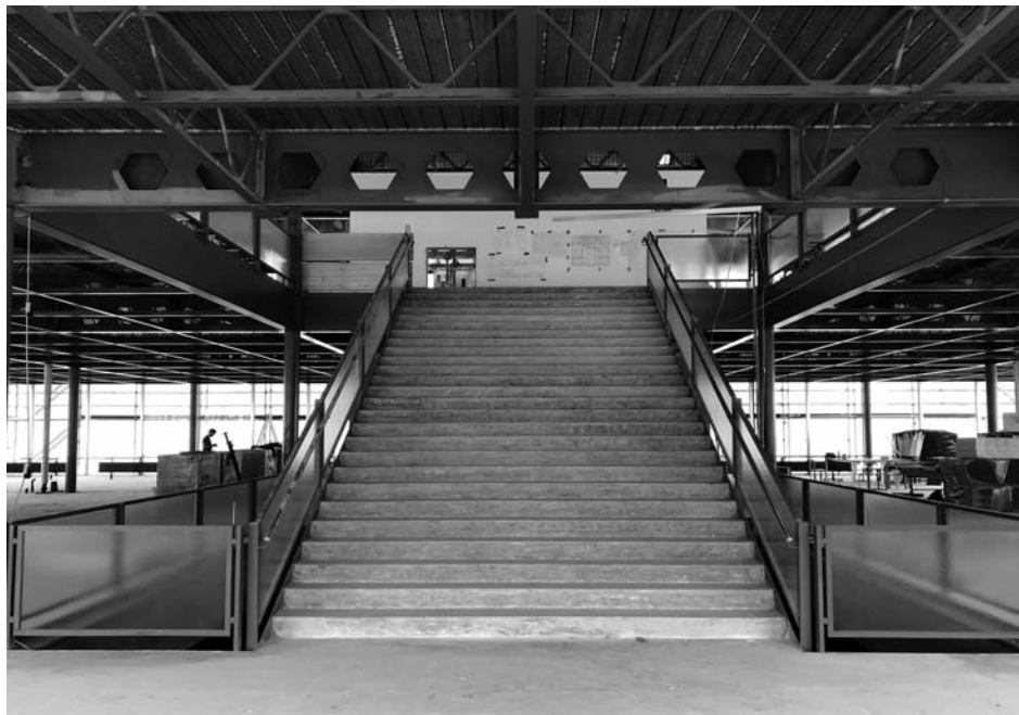
Auen – Treppenanlage im Rohbau
