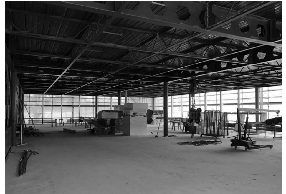
Auen – Klassenzimmer im Rohbau
