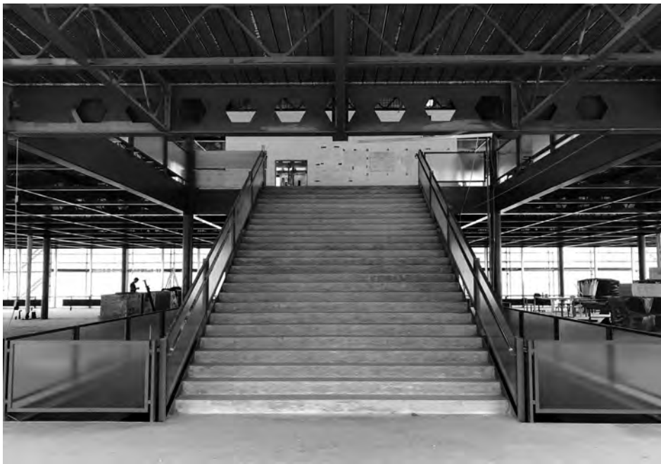
Auen – Treppenanlage im Rohbau
