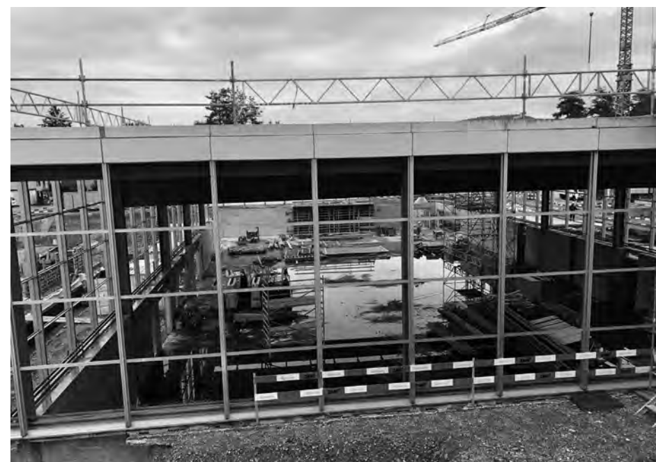
Auen – Sporthallenenerweiterung im Rohbau
