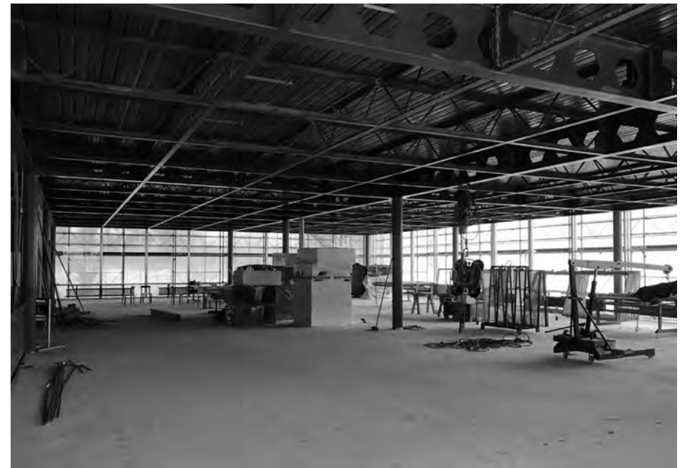
Auen – Klassenzimmer im Rohbau
