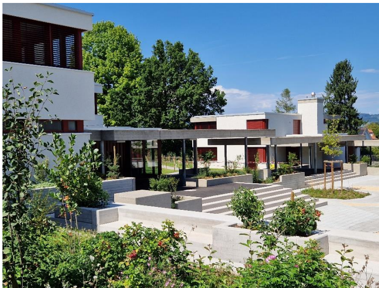
Neubau Schulanlage Schollenholz
