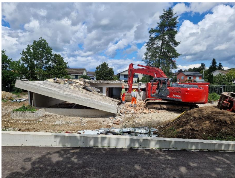
Abbrucharbeiten des Kindergartens
