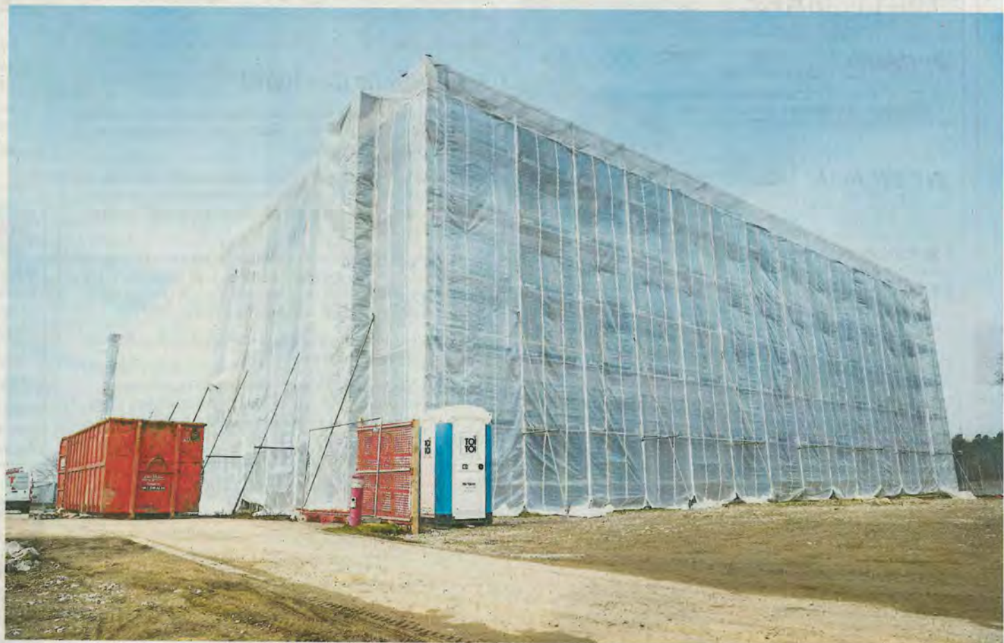
Eine Hülle schützt die Arbeiten im Innern des Hauptgebäudes Auen 1 vor Wetter und Kälte.
