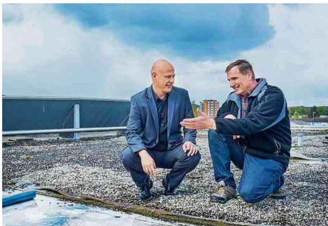
Leiter Schulanlagen Markus Herzog und Hauswart Walter Meier auf dem undichten Dach des Gebäudes Auen 1.
