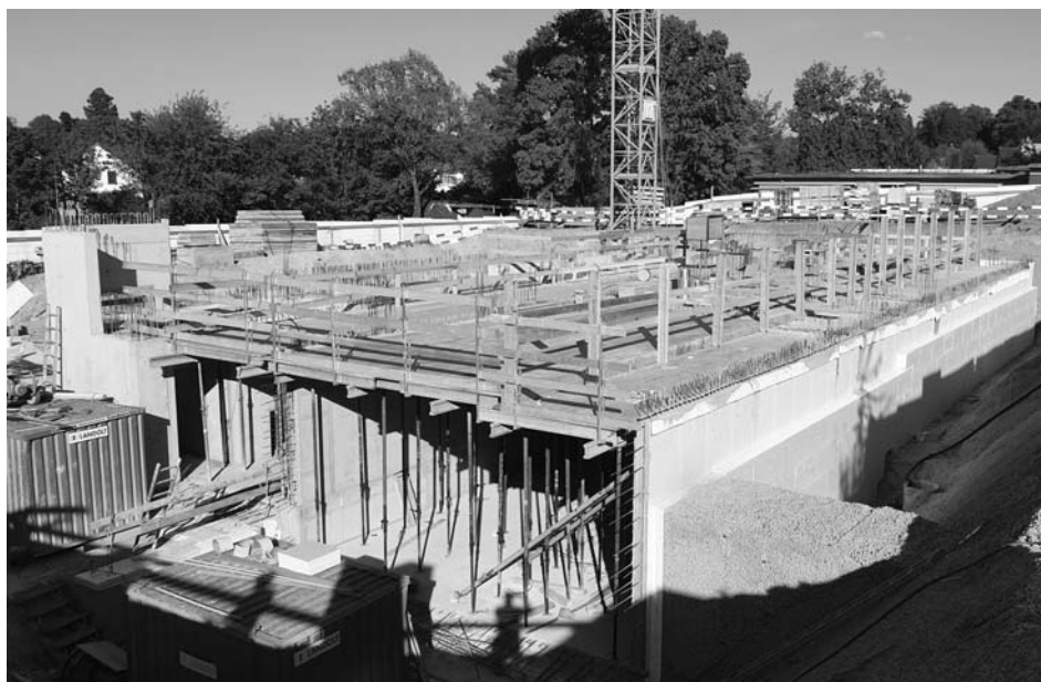
Neubau Schulanlage Schollenholz im April 2020
