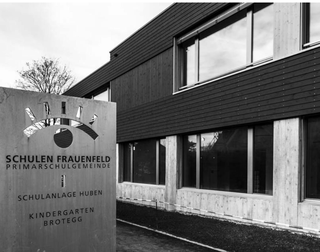
Neubau Doppelkindergarten Brotegg, Aussenansicht
