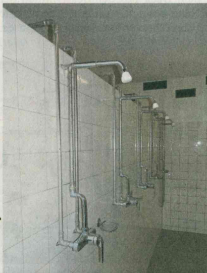
Blick in den Duschaum.
