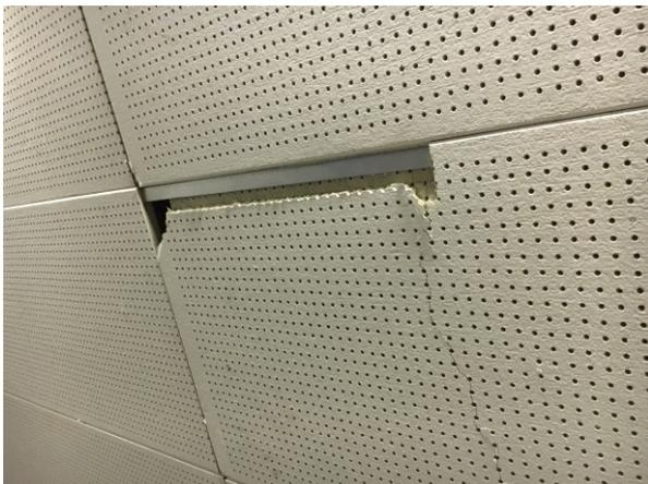
Deckenzustand – inkl. Asbestbelastung
